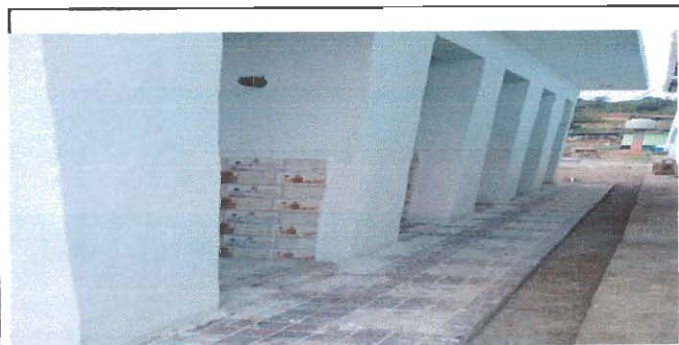
Foto 5: construcción de estructura de servicios sanitarios
