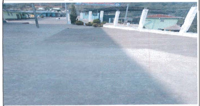
Foto 2: losa de patio construida
