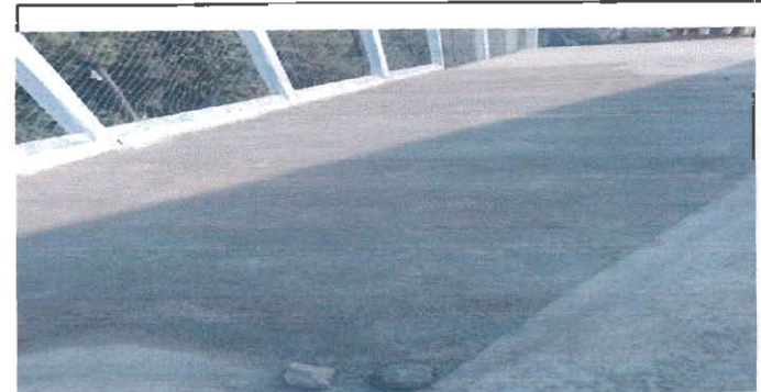
Foto 6: losa de patio construida
