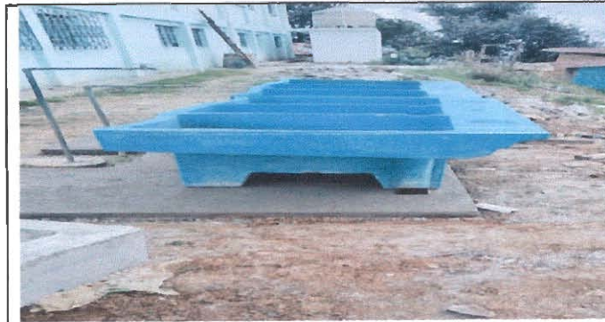
Foto 3: pila de dos lavaderos sustituida
